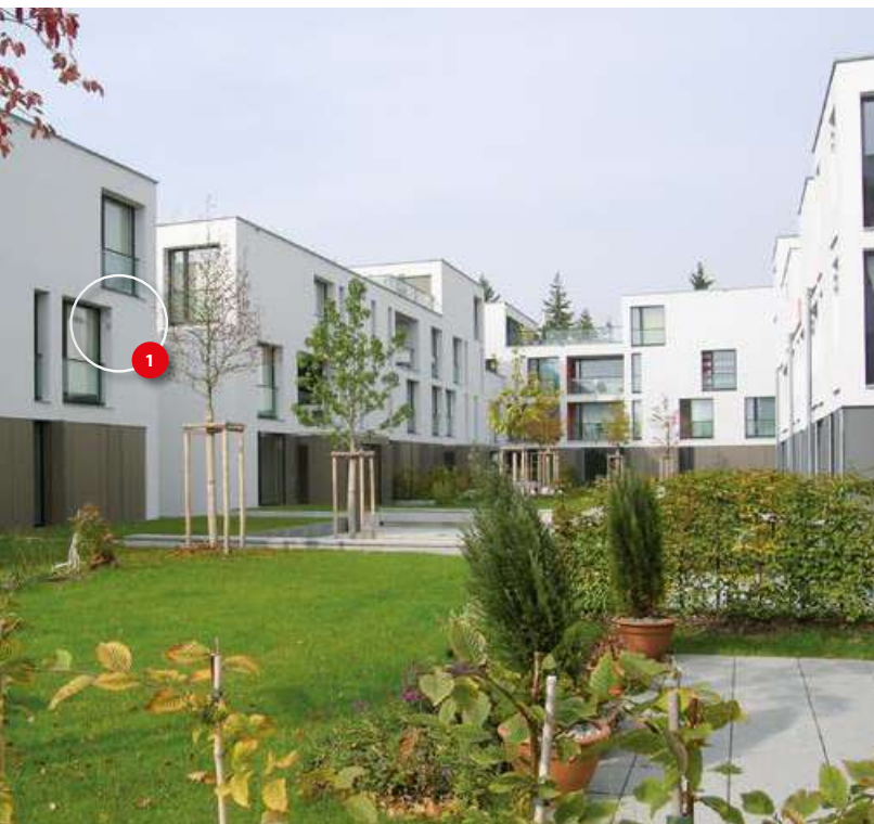
Skryté ukončení na fasádě pomocí vývodu v ostění okna
